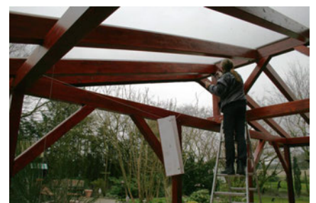
15) Drähte durch Konsolen der Hausseite lose durchziehen (damit beim Spannen noch eine Umwicklung eingehalten werden kann), und mit 12mm Schraube befestigen.
