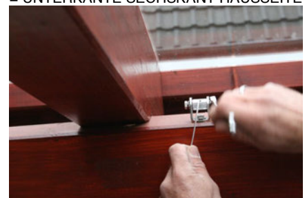
12) Draht an der Gartenseite durch den Sechskant führen und mit 10mm Schraubenschlüssel befestigen.
