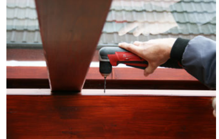
3) Mit 5mm Bohrer vorbohren.
