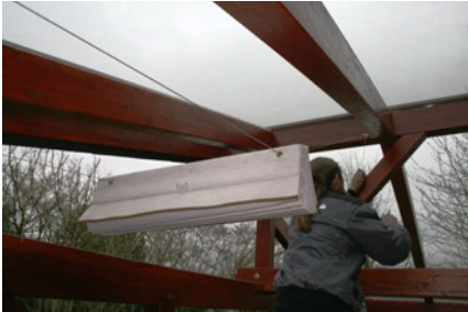
19/20) Mit dem nächsten Draht genauso verfahren.
