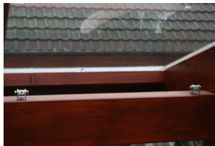
8) Fertig montierte Konsole, Sechskant lose angezogen.
