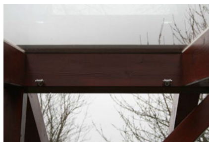
11) Fertig montierte Hausseite.
