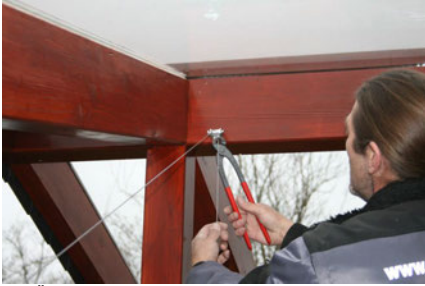
16) Überschüssigen Draht mit der Zange durchkneifen.
