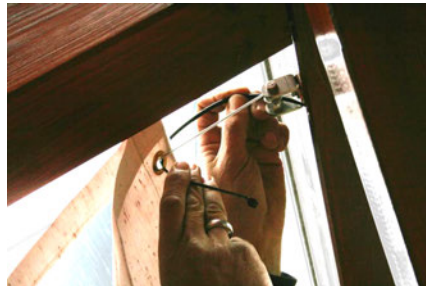
23) Die letzten Ösen des Baldachins an der Hausseite mit den Kabelbindern befestigen.
