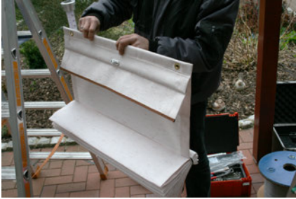
1) Baldachin aus der Folie nehmen, Kabelbinder nicht abknäueln.
