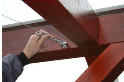
20) Draht an der hausabgewandten Seite spannen (10mm und 13mm Schlüssel). Der Draht muss unter den Sechskant laufen, und auch wieder nach außen zeigen.
