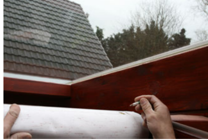
2) An der Gartenseite des Terrassendaches die Ösen zwischen den Sparren auf der Querfette anzeichnen.
