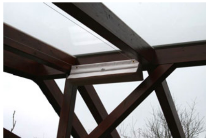
29) Fertig montierter Baldachin.
