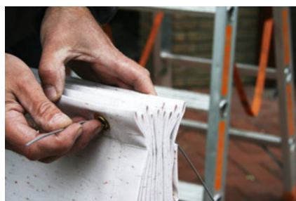
14) Jetzt die Kabelbinder des Baldachin abknäueln und den Draht durch die Ösen führen. Die Aluminiumschiene mit der angebrachten Aufnahme muss zur Gartenseite zeigen.
